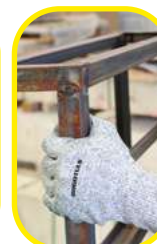
INSTALACIÓN DE ESTRUCTURAS
