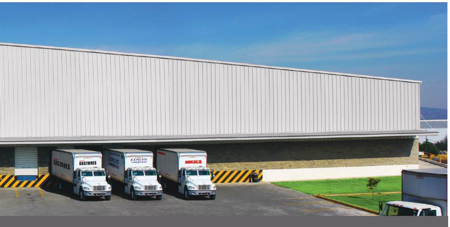
Racks de última generación / 9,980 posiciones en RACKS
