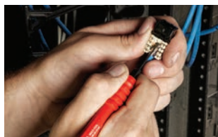
Pico para cables y gancho para quitar conexiones vagabundas
